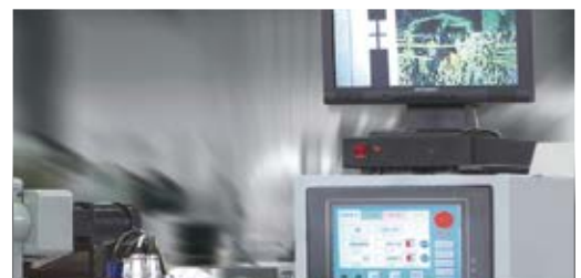
Sistema de control Central
